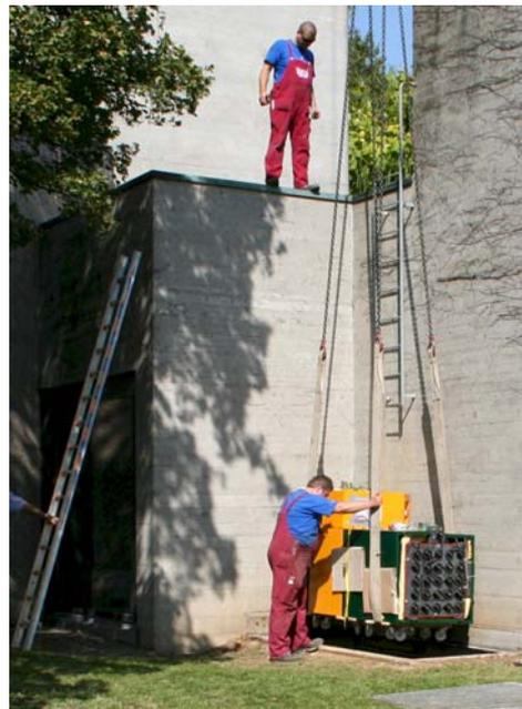
*Transport des Pelletskessels mit Kran in den Einbringschacht*
